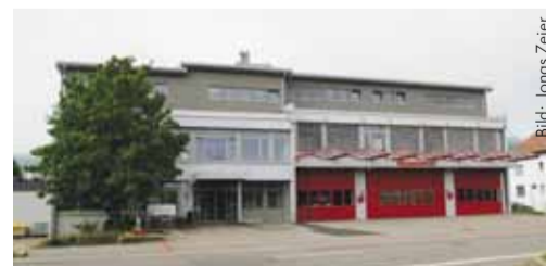
Das Feuerwehrmagazin Aesch wurde aufgestockt und erdbebensicherer gemacht.
